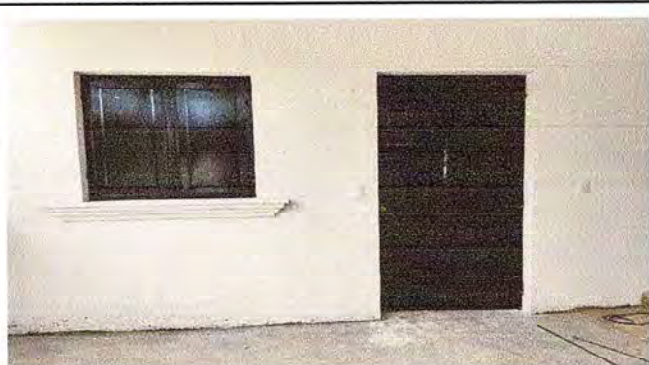
Foto 7: Imagen de puertas y ventanas recién colocadas en su respectivo lugar.
