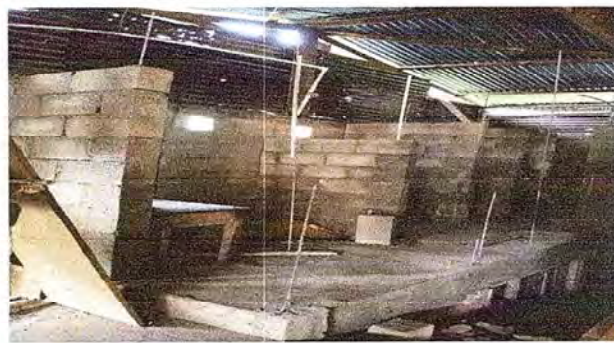
Foto 4: Fotografía de remozamiento de sanitarios para los niños y niñas de la escuela.
