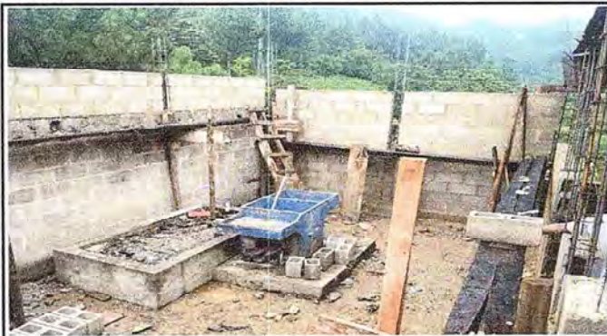
Foto 2: Fotografía de avance de remodelacion de pared de cocina.
