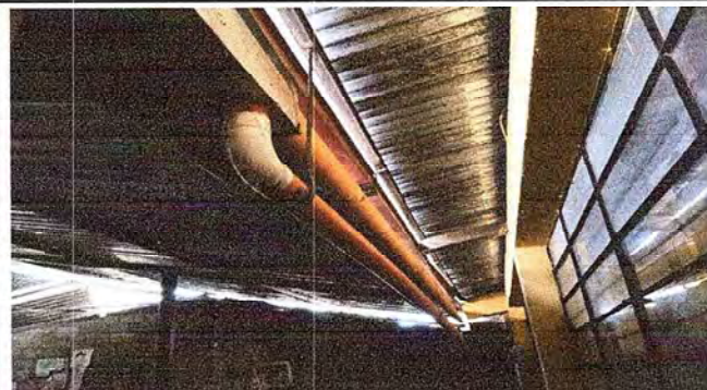
Foto 8: Canal de metal para agua pluvial colocado donde corresponde.
