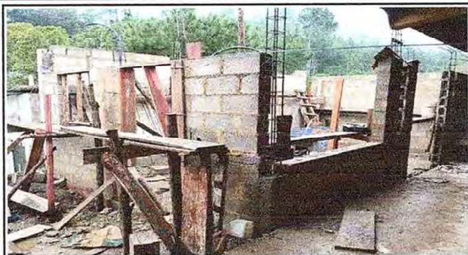
Foto 1: Habitación de paredes para cocina de establecimiento.
