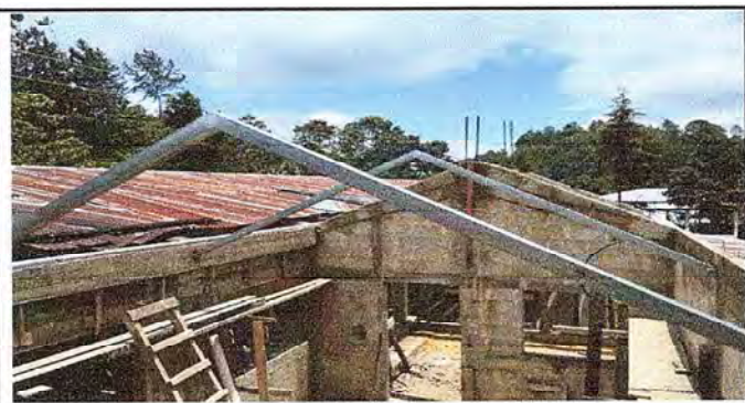
Foto 3: Estructura de techo y cubierta de lamina en proceso de ejecución.
